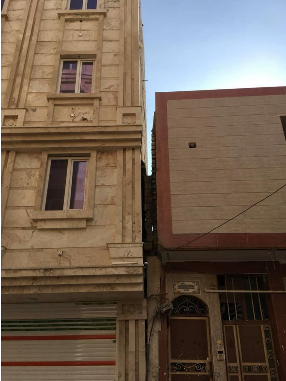
پروژہ: اجرای میکروپایل برای کنترل نشست پروژہ آبادان
