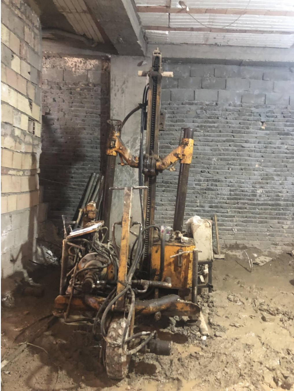
پروژه: اجرای میکروپایل برای کنترل نشست پروژه میدان شاپور
