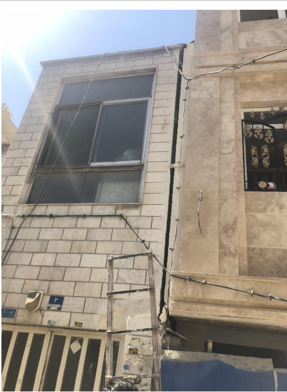
پروژه: اجرای میکروپایل برای کنترل نشست شهری
