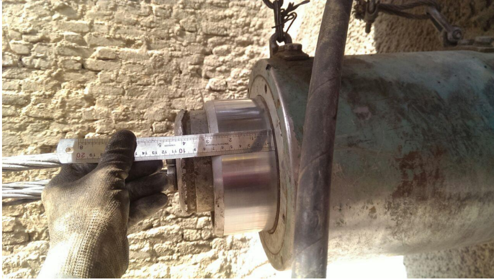
انجام آزمایش کشش مهارهای تنیده
